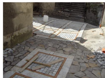
Operazione di posa della pavimentazione
