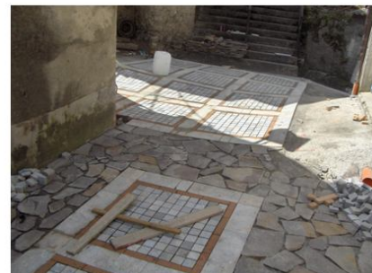
Operazione di posa della pavimentazione
